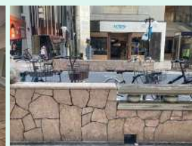
駐輪場外周の腰壁
