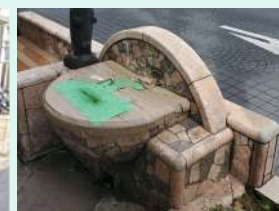
閉鎖された水飲み場
