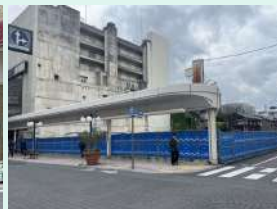
アーケードに面する空き地
