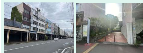
変化が少なく長大な印象の壁面 憩いの広場とのつながりの弱さ
