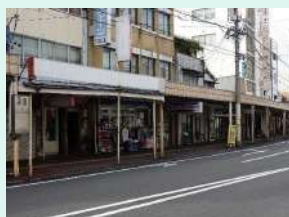
老朽化が進むアーケード
