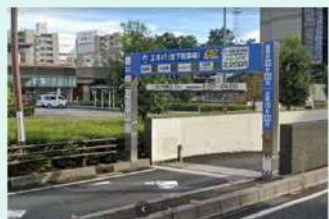
老朽化した地下駐車場
