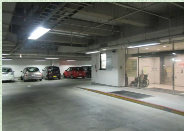
地下駐車場 収容台数36台
