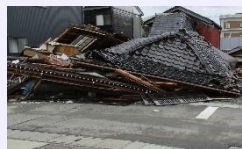
地震により倒壊した住宅の様子 出典:(一財)消防防災科学センター
