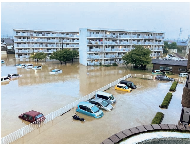
2022年台風第15号における浸水被害
