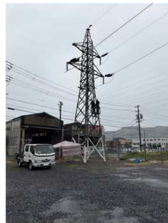
実動訓練実施場所（鉄塔）
