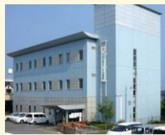
世代間交流センター (3館)
