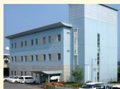
世代間交流センター （3館）
