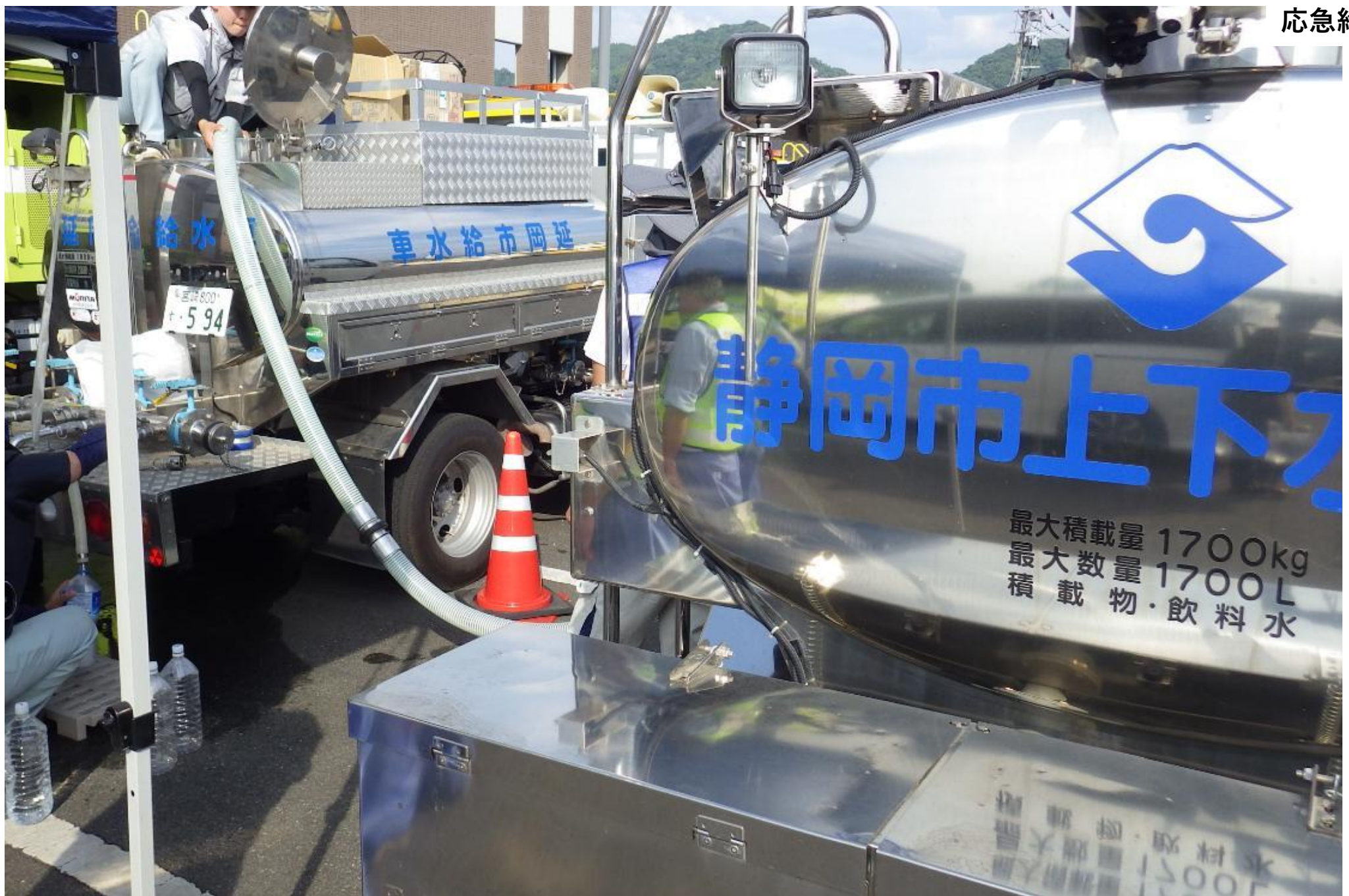
市民への給水を行う他事業体給水車への補水作業
