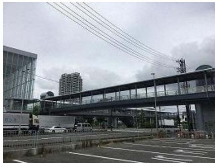
清水駅東口歩行者デッキ延伸事業
