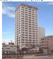
真砂町プラザ第1地区優良建築物等 整備事業(バスター清水)
