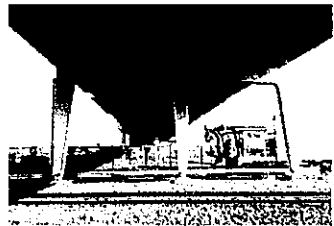
長沼大橋ロッキング橋脚
