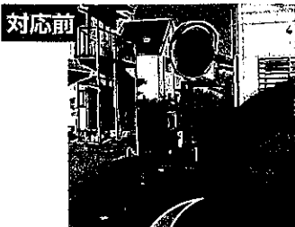
【下川原】カーブミラー改修
