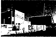
高橋雨水ポンプ場
