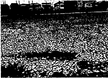
清水六中 グランド被災状況
