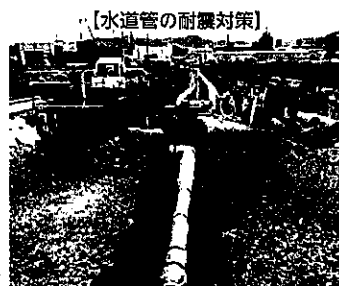
耐震化された水道管への布設替
