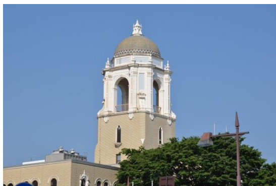
静岡市役所本館（議会棟）
