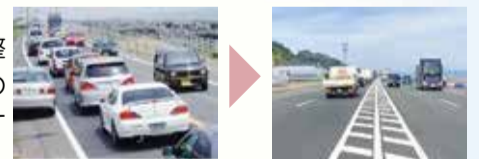
・社会インフラ整備の例：国道150号(久能)拡幅整備
