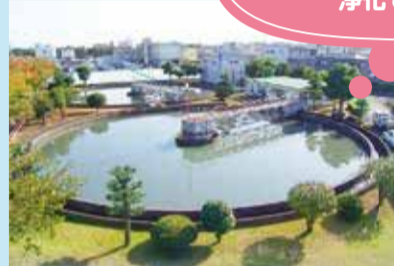
高松浄化センター(下水処理場)
