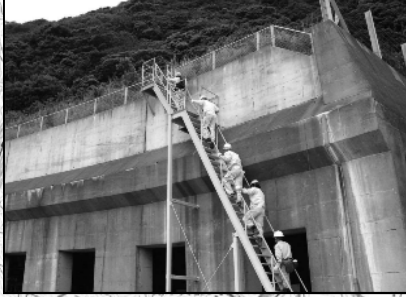
洞門点検状況
