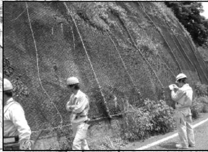
法面点検状況
