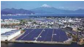
太陽光発電設備
