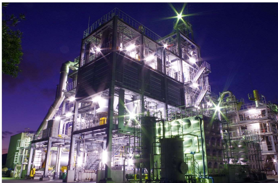
中島浄化センター汚泥燃料化施設
