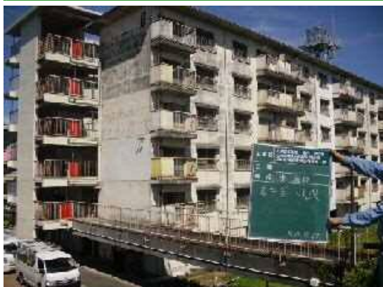
市営住宅の長寿命化（施工前）
