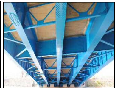
道路橋りょうの長寿命化(施工)
