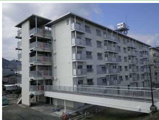
市営住宅の長寿命化（施工後）
