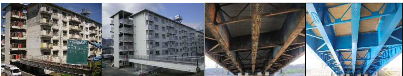
市営住宅の長寿命化（施工前・後）
