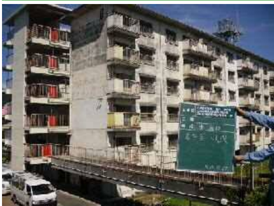
市営住宅の長寿命化（施工前）
