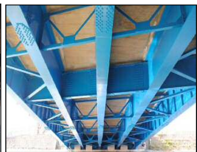
道路橋梁の長寿命化（施工後）
