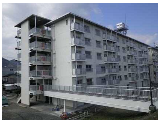
市営住宅の長寿命化（施工後）
