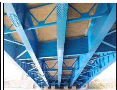
道路橋梁の長寿命化（施工後）
