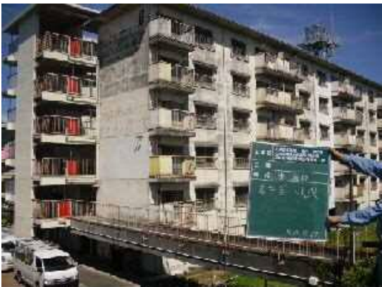
市営住宅の長寿命化（施工前）
