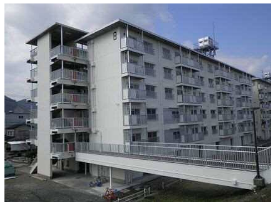
市営住宅の長寿命化（施工後）
