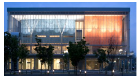
PFI事業で運営する 静岡市清水文化会館(マリナート)
