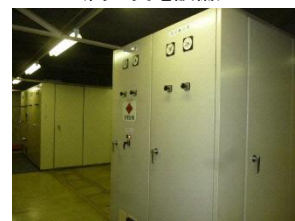
【地下2階に設置している設備機器】 (高圧受電設備)
