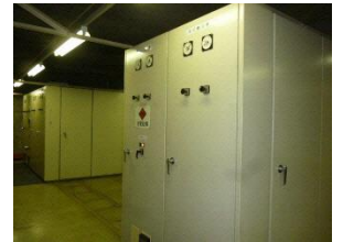
【地下2階に設置している設備機器】 (高圧受電設備)
