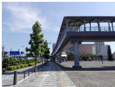
JR清水駅周辺の ペDESTリアンデッキの整備状況
