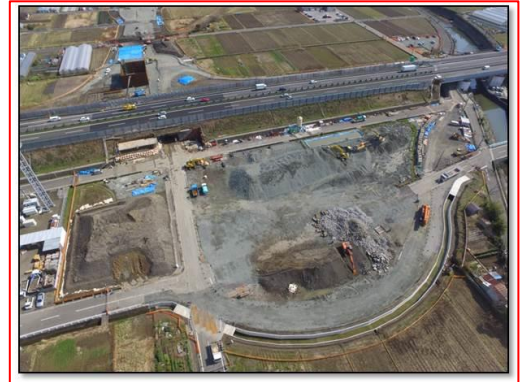
◆新 IC 工事現場（北側上空より）
