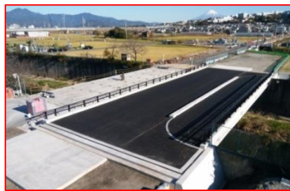
◆アクセス道路広野大谷線水上 2 号橋
