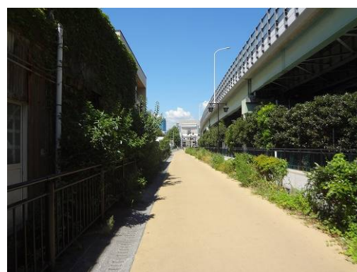
⑤高架道路と並行する箇所
