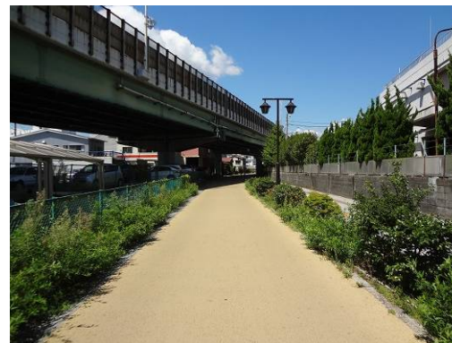
④高架道路と交差する箇所
