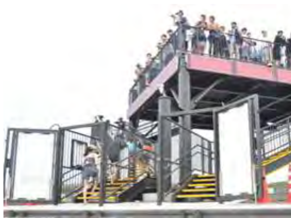
津波避難施設
