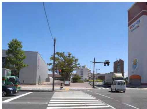
植栽や老朽化した倉庫等により、港(船溜り)への見通しが遮られる
