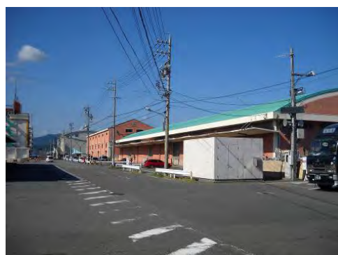
老朽化した上屋(4号、5号上屋)
