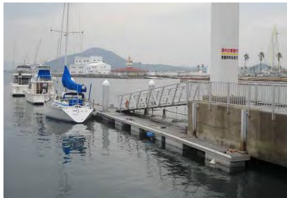
ビジターバースのイメージ。図面上は、20×2mの浮棧橋で片側2～3隻係留可能となっている。
