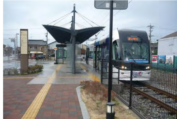
バス停 LRT の駅が一体化した例 (富山市岩瀬浜)
