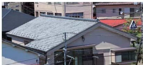
健全な瓦屋根
