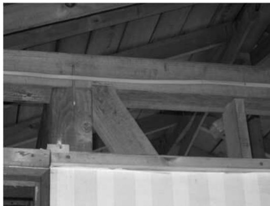
写真Ⅱ.2.2.4 柱頭接合部の例 (金物が使われていない例)
