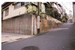
擁壁や坂 に面する
