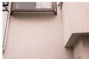
健全な外壁（ひび割れ等がない）
