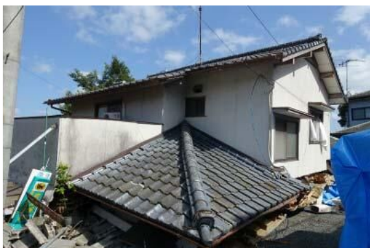
写真2 倒壊した木造住宅
