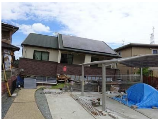
写真4 倒壊した木造住宅
