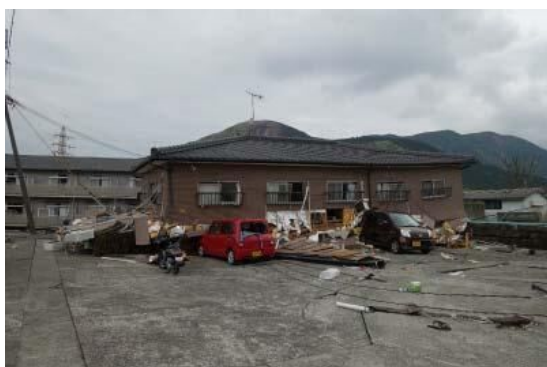
写真 14 倒壊した木造アパート
