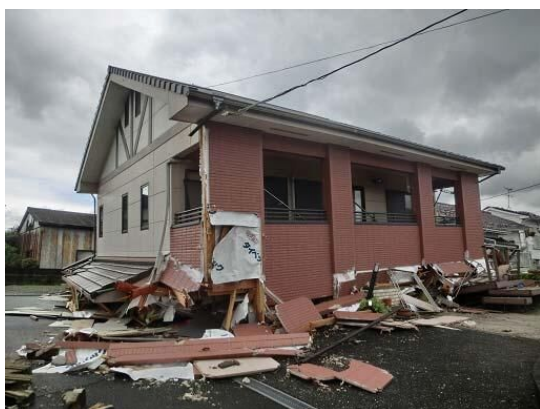
写真6 倒壊した木造住宅
