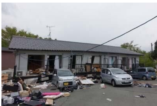
写真 12 倒壊した木造アパート
