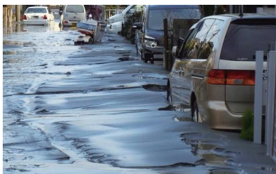
液状化で砂がふき出した例
