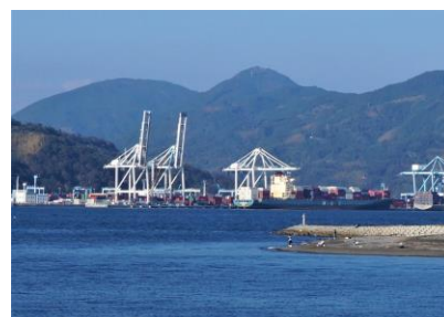
コンテナクレーン（清水港・みなと色彩計画に基づく色彩）
