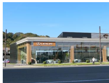
ガラス素材と壁面後退により開放的な店構え
