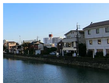
川に対して窓など開口部を設けている建築物
