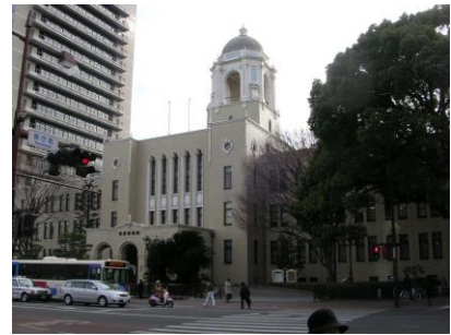
市役所静岡庁舎本館
