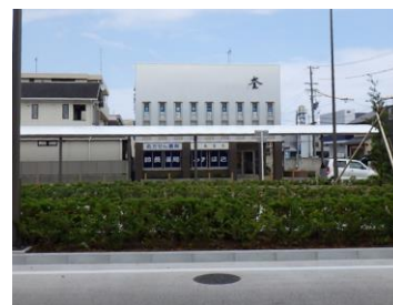
駅前広場に面してすっきりとした表情の建物
