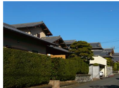
屋根の形状や生け垣が連続する良好なまち並み
