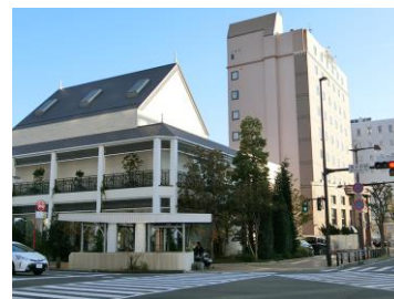
中高木の植栽により、街路樹と一体となって緑の空間を創出
