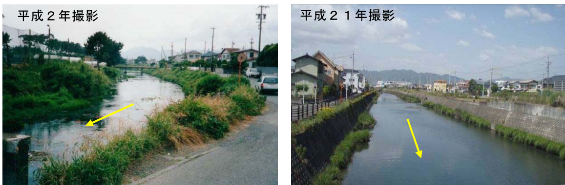
図 2-4 治水事業完成区間の状況（西前橋より上流を望む）
