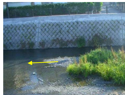
図 4-18 環境護岸の実施箇所
