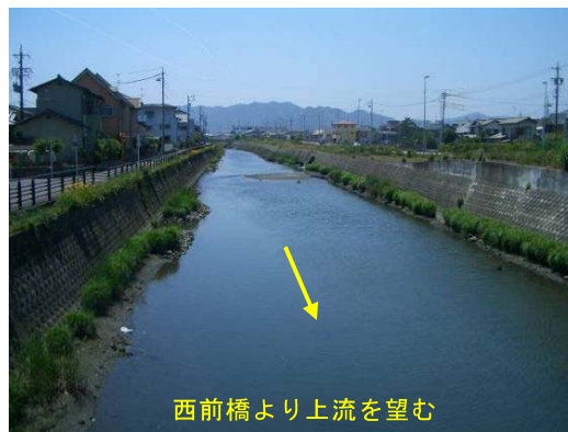
図 2-19 下流部の河道状況
