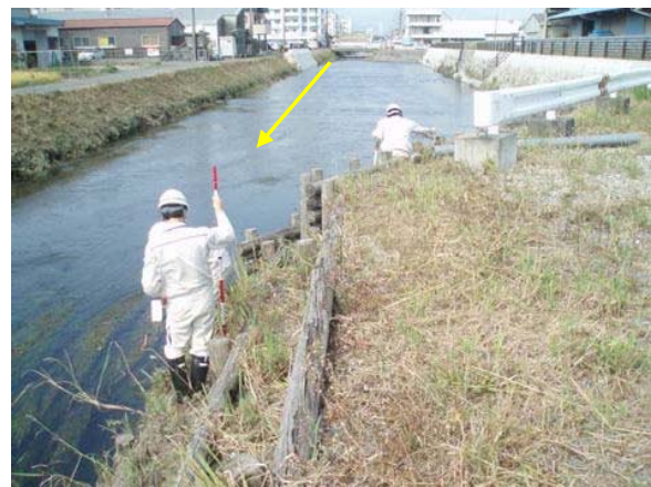
図 4-19 河川パトロールの状況
