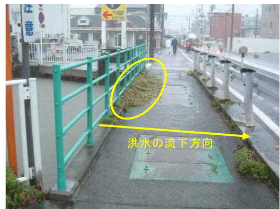
③浜川念仏橋の溢水状況
