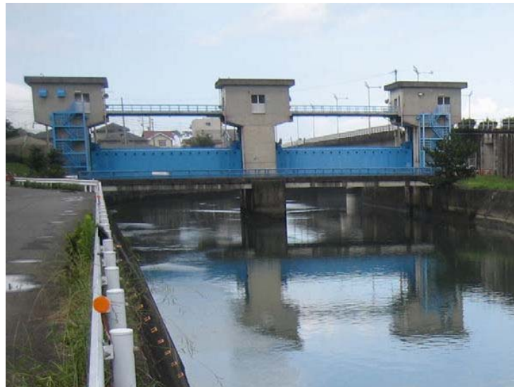
図 2-8 浜川水門（H1.3 完成）
