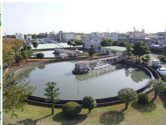
図 2-16 高松浄化センター
