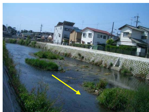
図 1-25 浜川上流 -護岸整備箇所-
