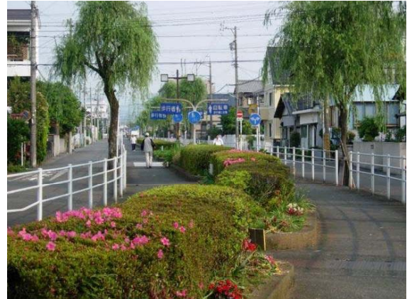
図 2-14 下水道暗渠部の歩行者道及び自転車道
