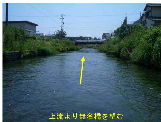
図 2-23 上流部の河道状況
