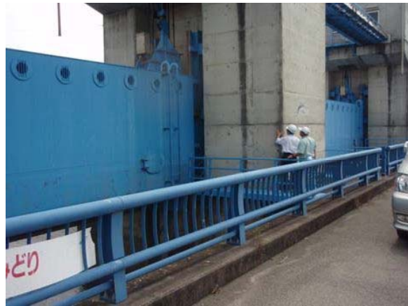
図 4-20 浜川水門の点検状況
