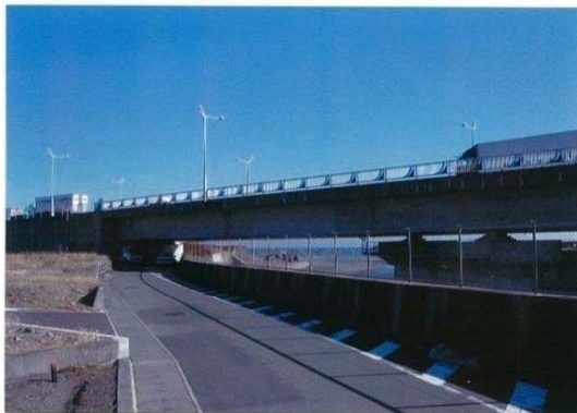
図 1-27 パラペット堤 (浜川左岸：津波対策)
