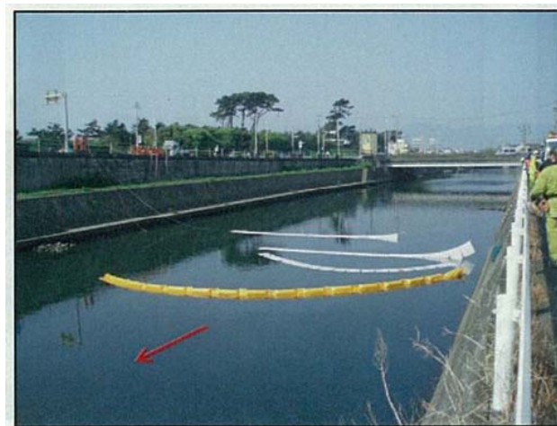
図 2-18 水質事故の対応 (オイルフェンス・オイルマットの設置)
