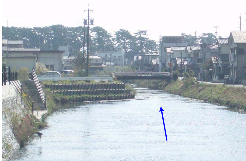
図 4-8 未改修区間と無名橋
