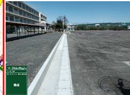
高松中学校 (R7度完成)
