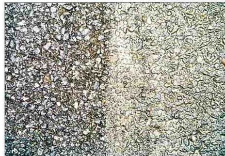
図 8-4 透水性舗装清掃後(右)と清掃前(左)
