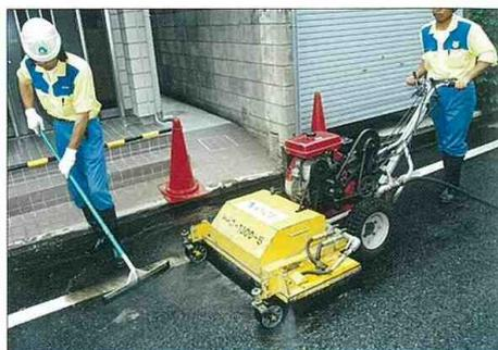
図 8-3 透水性舗装の清掃状況
