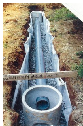
図 7-6 浸透ます、透水管の据付
