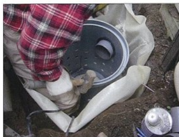
図 7-6 浸透ます、透水管の据付
