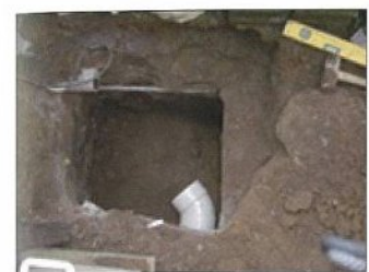
図 7-2 掘削状況 (浸透ます)
