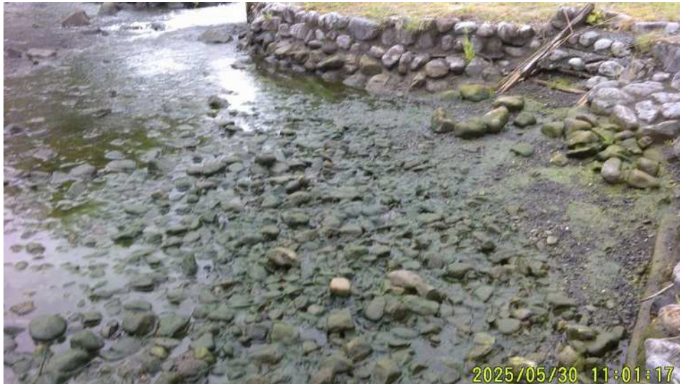
【第2池：水抜き後の藻の状況】
