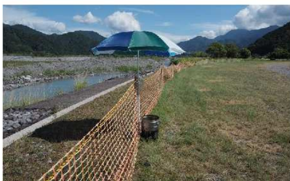
写真 12)安全対策ビニールネット
