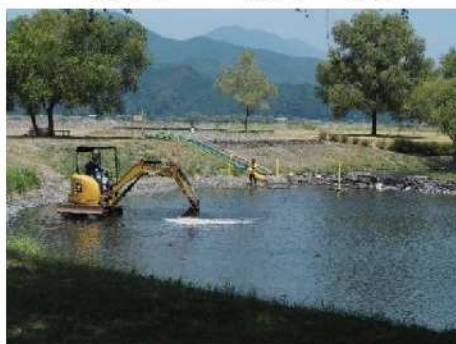
写真 22)大池の藻除去・清掃工事
