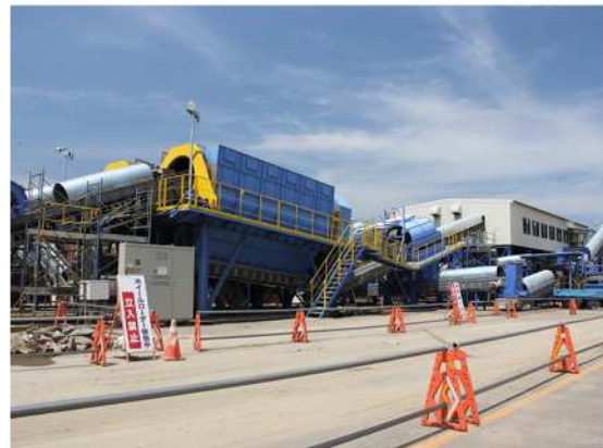
東日本大震災 二次仮置場
