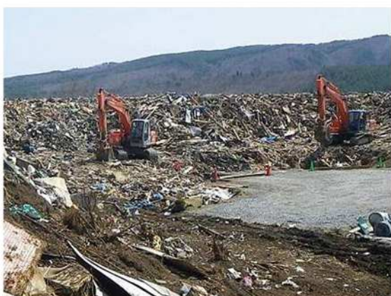
東日本大震災 一次仮置場における機械による粗選別
