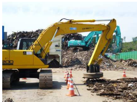
重機を活用した選別処理
