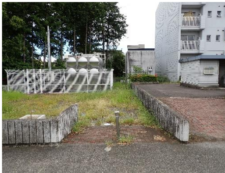
令和3年度 上土団地第15号棟 給水改修工事
