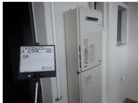
令和2年度 清水高部団地第5・6号棟 ガス給湯設備改修工事
