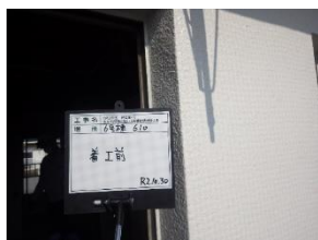
ガス給湯設備
