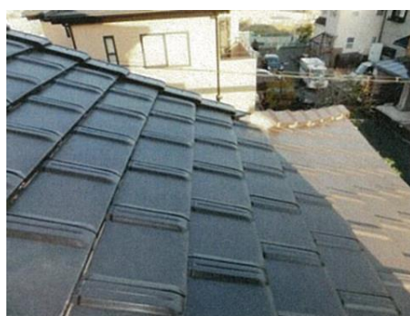
屋根改修の事例
