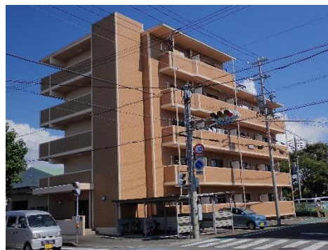
プレジール下川原 外観
