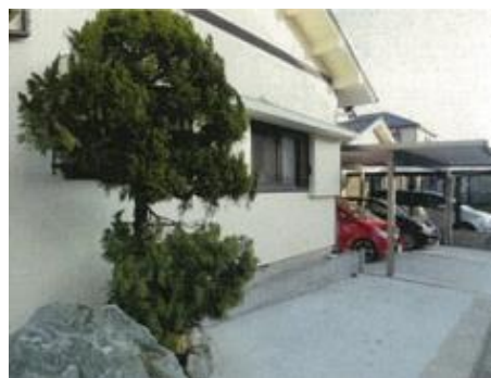
外壁改修の事例
