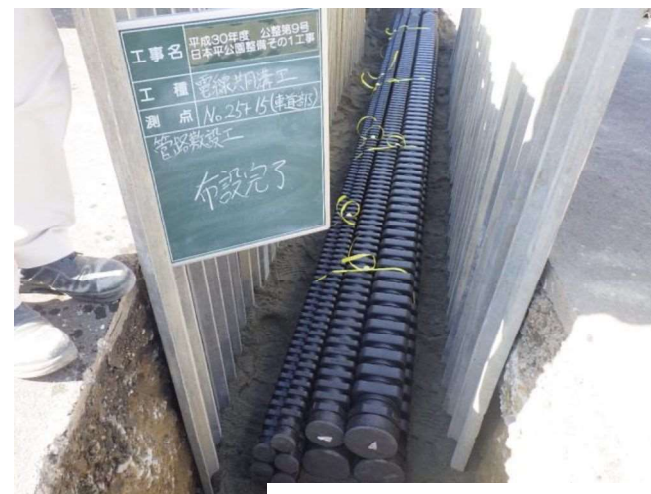
【電線管路布設状況】
