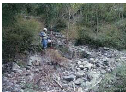
斜面の安定度を調査
