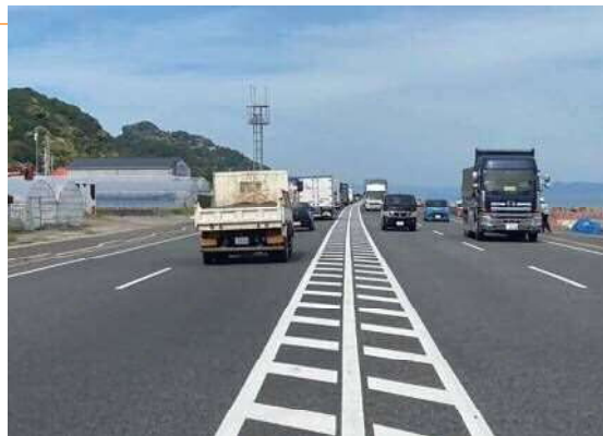
整備の状況(駿河区西平松)
