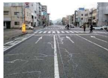
② シール材注入
