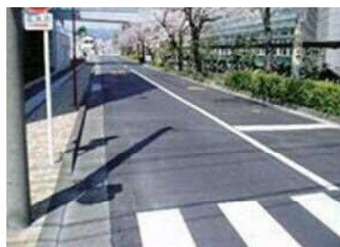
① 加熱薄層舗装
