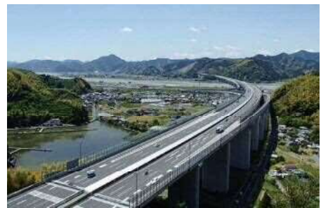
交通状況(新静岡IC付近)
