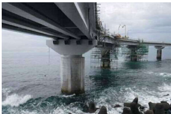
橋脚補強(巻立て工法)の実施状況
