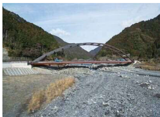
整備中の大河内橋の様子
