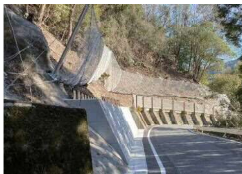
落石防護柵を設置し道路利用者の安全を確保する
