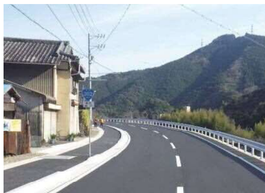
歩道設置による安全な歩行空間確保
