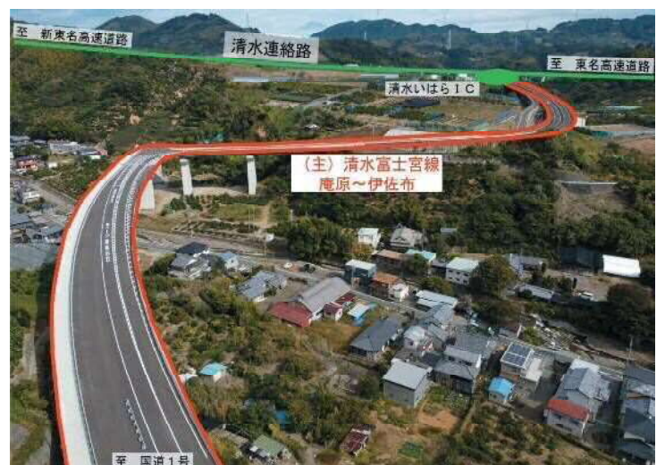
事業箇所(一部)
