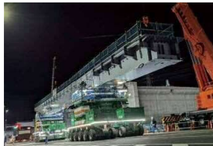
清水立体(施工状況)
