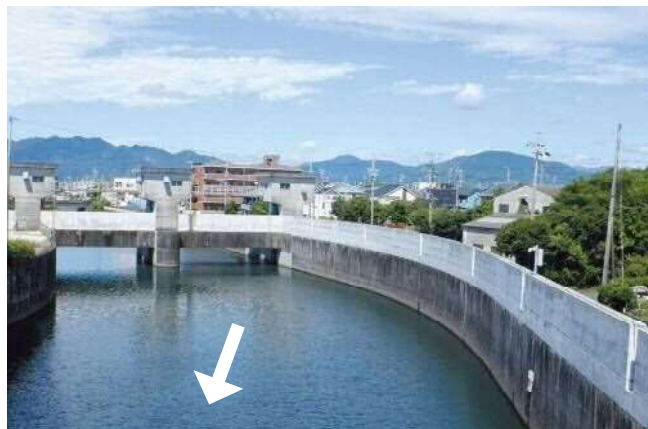
対策後の河口～浜川水門
