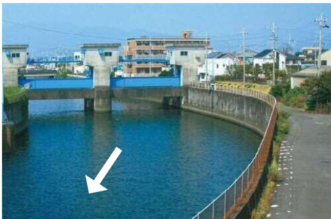
対策前の河口～浜川水門
