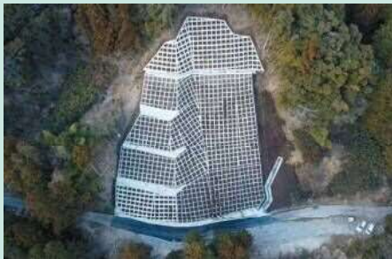
R5.2 工事完成
