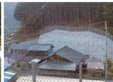
施工後（葵区渡寺山内内）
