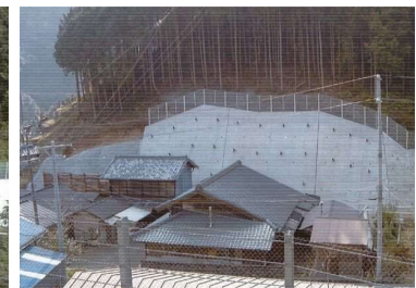
施工後（葵区渡寺山内）
