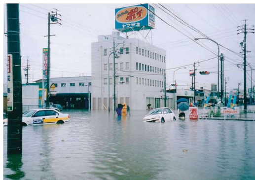
豪雨による市内の浸水状況(平成16年6月)
