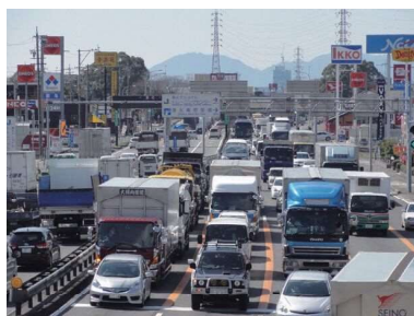
清水立体(着手前)
