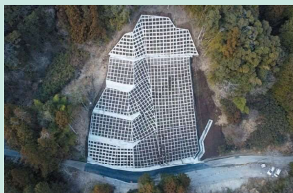
R5.2 工事完成
