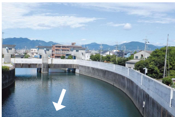
対策後の河口～浜川水門
