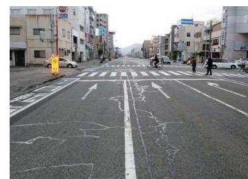
② シール材注入
