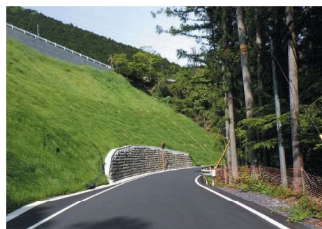
切土、植生マット、吹付砕工を実施し、道路利用者の安全を確保する
