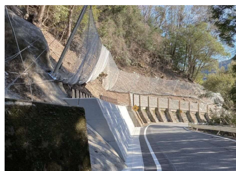
落石防護柵を設置し道路利用者の安全を確保する
