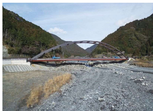
整備中の大河内橋の様子
