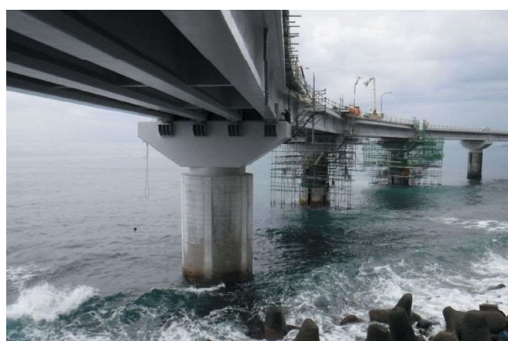
橋脚補強(巻立て工法)の実施状況
