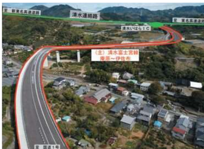
事業箇所（一部）
