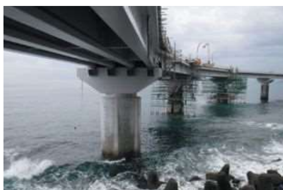
橋脚補強(巻立て工法)の実施状況
