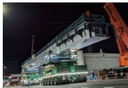
清水立体(施工状況)
