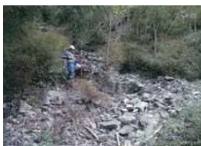
斜面の安定度を調査
