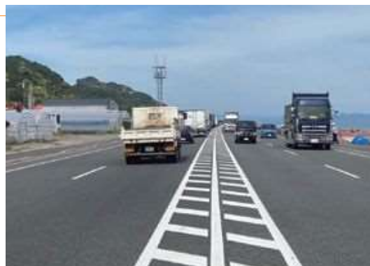
整備の状況（駿河区西平松）
