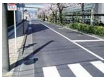
①加熱薄層舗装
