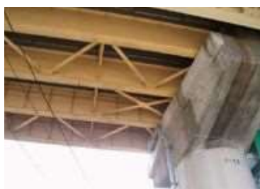
◆ 耐震補強の事例（落橋防止システム設置）
